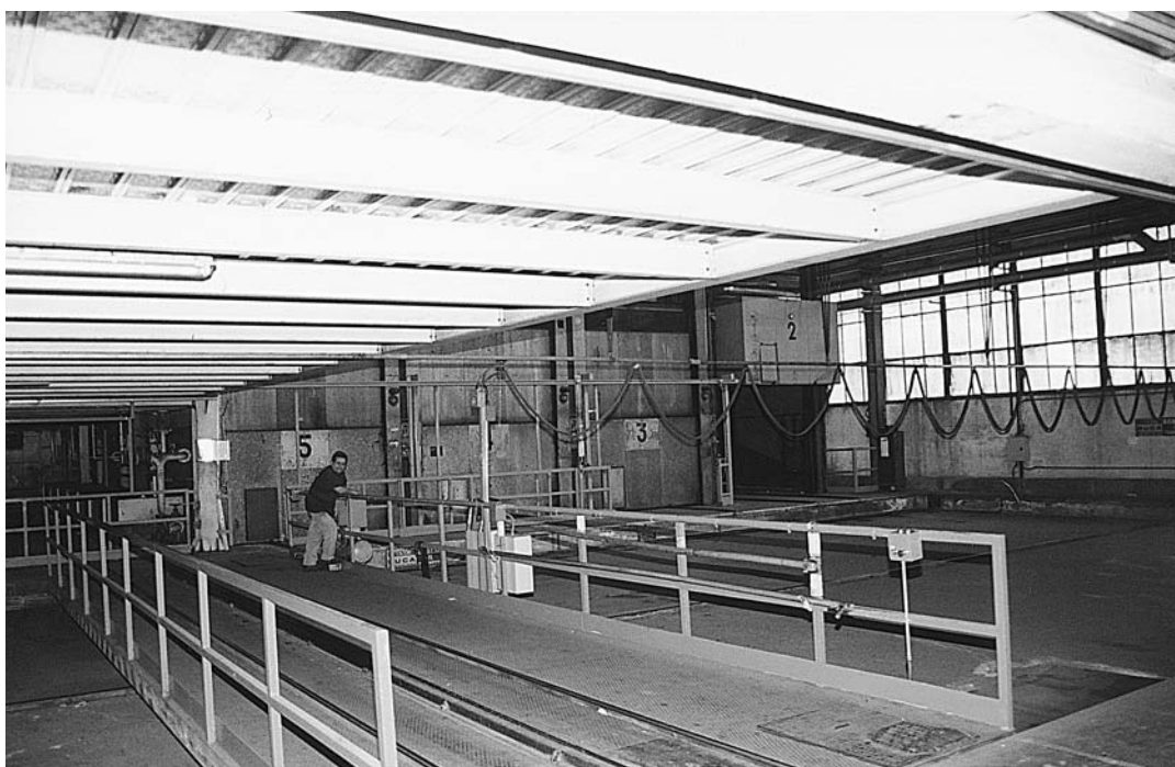
Fig. 13 - Vista generale dei forni di cottura vernici di fondo e di finitura, sottostanti alle cabine aeree di verniciatura. Le strutture verniciate all'uscita dei forni vengono rilevate dal carrello di traslazione - ora in attesa dell'apertura del forno 3 - per essere inviati nell'area di assemblaggio
