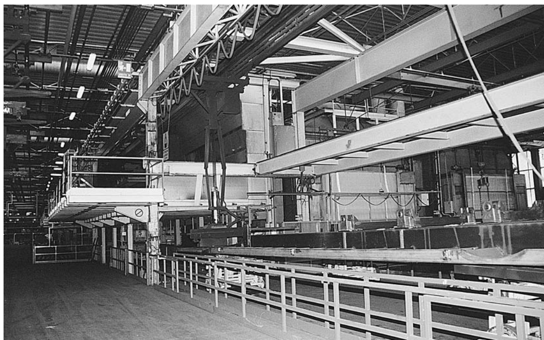
Fig. 5 - Il telaio agganciato viene sollevato e trasportato verso la cabina aperta, sistemata al piano rialzato del reparto. Si noti a sinistra il "terrazzo" dove scorre, su un binario, il robot di spruzzatura per verniciare il rimorchio, che ha una lunghezza di oltre 13 metri
