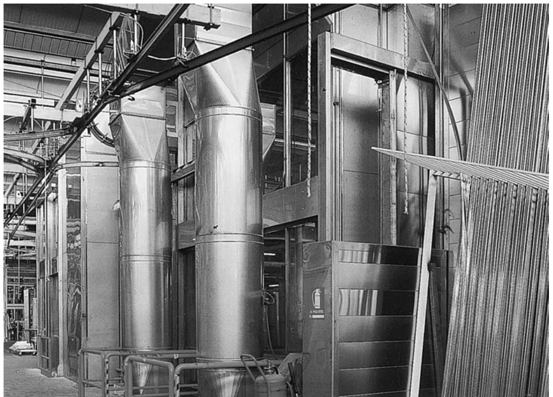
Fig. 8 - Dall'esterno, le due cabine (in primo piano la cabina manuale a secco, dietro la cabina automatica)
